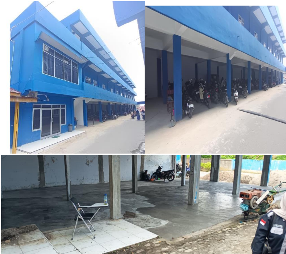
Gambar 2.3.1 Gedung Aula Mini Serta Lahan Parkir
